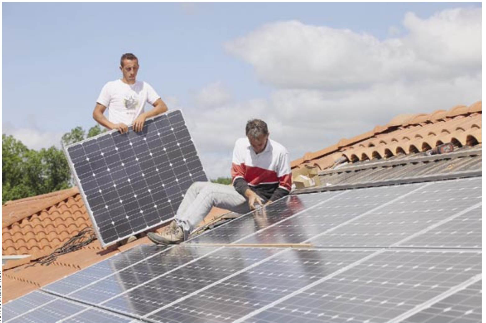
Pose de panneaux photovoltaïques sur le toit d'une école par une association de production citoyenne et locale d'énergies renouvelables (Puy-de-Dôme).
